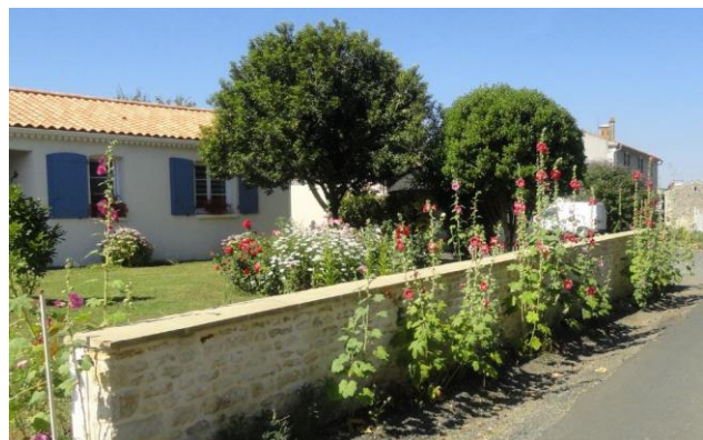
Muret bas en pierres sèches en bordure de rue
