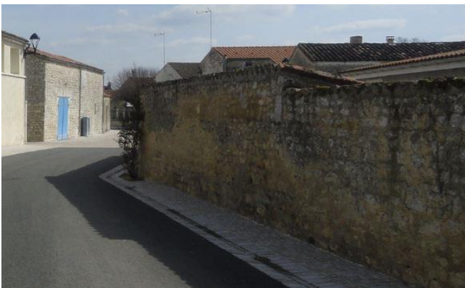
Mur en pierres sèches à préserver dans le bourg de la Gripperie
